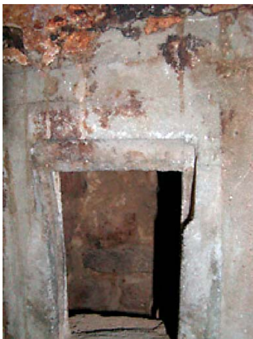
Ilustracija 1 Otvoren sabirač čađe dimnovodnog kanala
